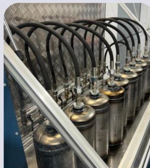
УЧАСТОК ГИДРОСТАТИЧЕСКИХ ИСПЫТАНИЙ
